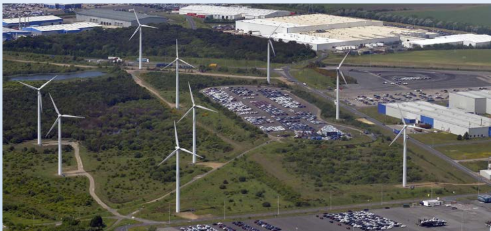
英国日産の工場内に導入されている風力発電機
