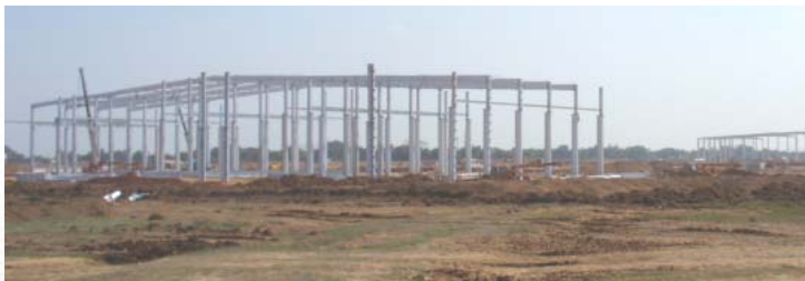
インド・チェンナイ工場建設地
