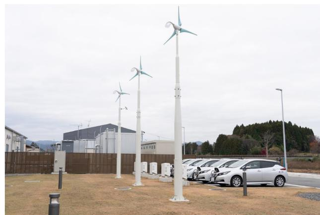
具体的には、浪江町にある商業施設「道の駅なみえ」が保有する、RE発電設備および、PCS（パワーコントロールシステム）と浪江町の公用車であるEV「日産リーフ」を活用し、日産の充放電制御システムをPCSに搭載することで、効率的なエネルギー運用を検証し、クリーンエネルギーの地産地消を促進するエネルギーマネジメントシステムの構築を目指します。
