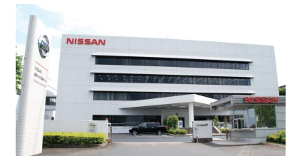
日産カスタマーサービスセンター
