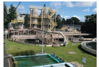
水処理場 Water treatment facilities
