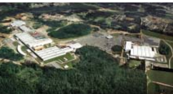
ブラジルに完成したルノー・日産共同工場
