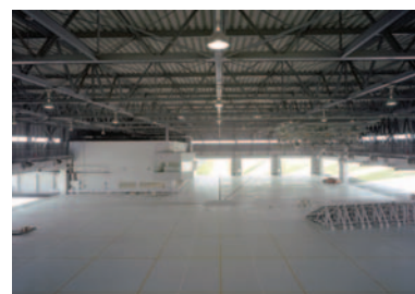
衝突実験棟内部
