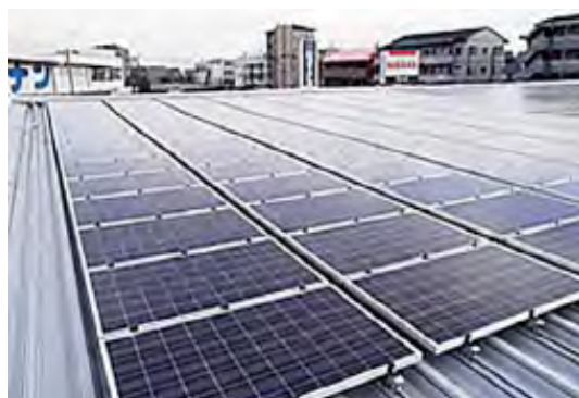
神奈川日産自動車(株)の一部の販売店の屋根に設置した太陽光パネル。得られた電力を日産がPPSとして調達し販売店に供給しています
