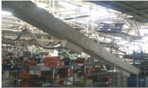
エアダクト倒壊
